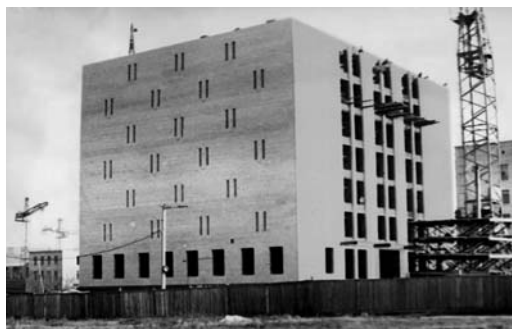
Возведен 7-й этаж
