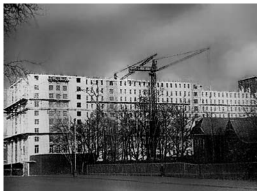
Общий вид строительства корпуса «Г» здания госархивов СССР. Фото 1957 г.
