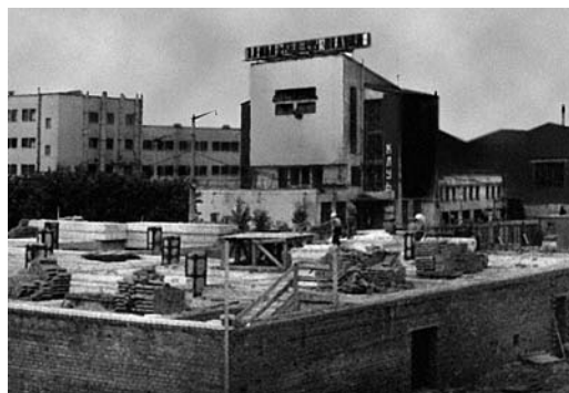
Вид стройплощадки на фоне клуба Дорхимзавода
